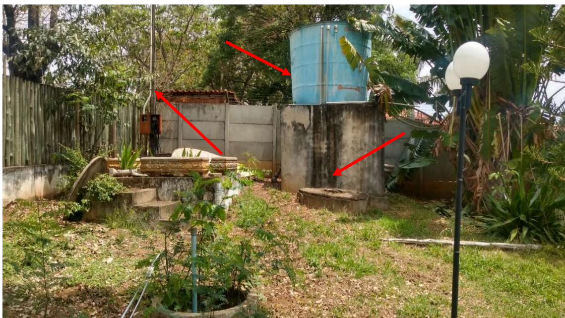
Imagem nº 03: Vista do reservatório de água, do poço semi-artesiano e do poste de entrada de energia.
